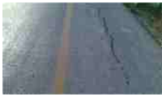
Fig.2 Longitudinal cracks
