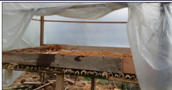
Figure 1: Construction du germoir traditionnel.
